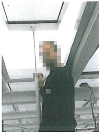
Bild 3 Die erforderlichen Rauch- und Wärmeabzugsklappen sind in dem erneuerten Glasdach integriert worden
