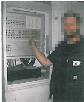
Bild 4 Durch eine Änderung der Ansteuerung der Dachklappen und der vorhandenen Fassadenklappen über die GLT ist nun eine Nachtauskühlung des angrenzenden Atriums möglich, die den inneren massiven Baukörper als Speichermasse nutzt
